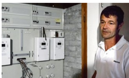
Thomas Baumann, hier mit Elektro-Installationen im Keller, hat die Elektra-Solaranlage gebaut.
